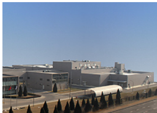
天津田辺製薬 新製剤棟外観
