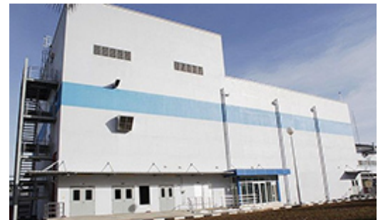
タナベインドネシア・バンドン工場 新製剤棟
