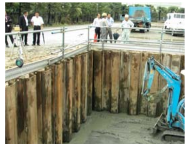
汚染土壌の掘削除去
