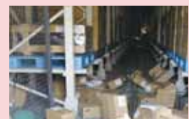
震災直後の自動立体倉庫内
