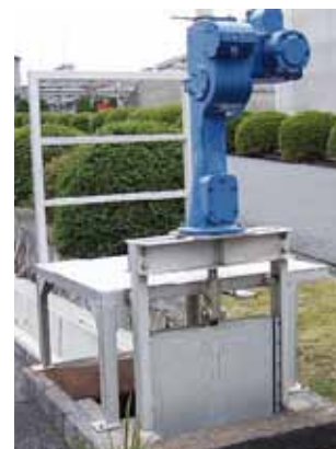
構内に設置された手動ゲート
