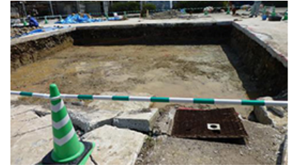
吉富工場の土壌改良工事
