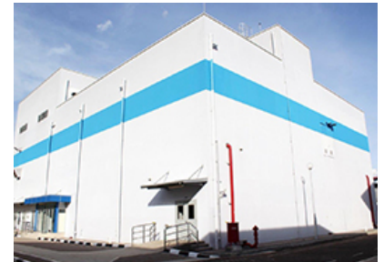
タナベインドネシア 新製剤棟外観
