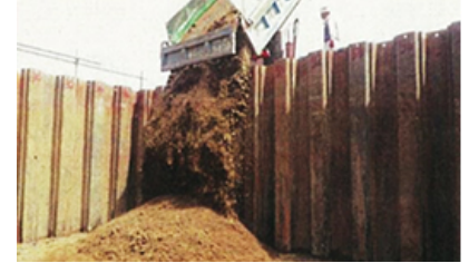
旧鹿島工場の土壌改良工事
