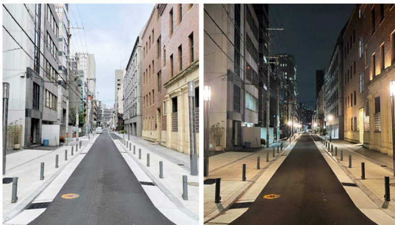
道修町通再生プロジェクトによる道路整備
