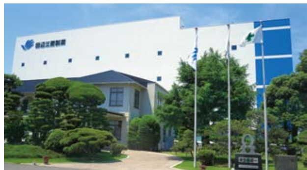
吉富工場新製剤棟
